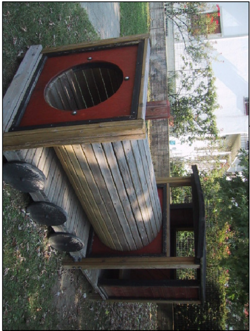
Gioco locomotiva da mantenere con applicazione di fondo a base di resine e posizionamento di tappetino antitrauma sulle parte anteriore
