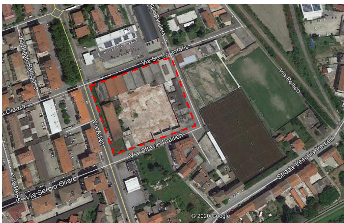
Figura 1 – Immagine aerea dell'ambito territoriale di progetto. (riquadrate in rosso l'area "ex Marietti")
